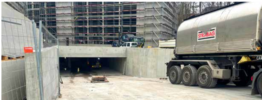
Zu- und Abfahrt des neuen Parkhauses
