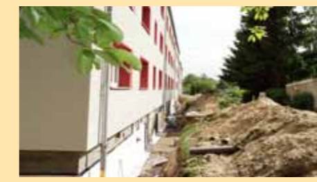
Puschkinstraße 7-13: Kellertrockenlegung und Dämmung
