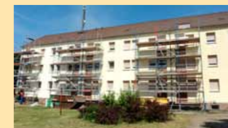
Balkonanbau in Schönow
