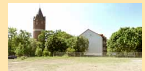
Abriss ehemaliges Heizhaus Kreisverkehr Oranienburger Straße
