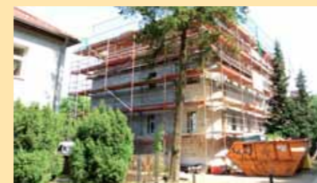
Oranienburger Straße 8: Komplettsanierung
