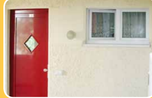
Bürgermeisterstraße 1-7: Einbau neuer Küchenfenster
