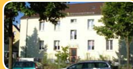
Karl-Marx-Straße 98-100: Fassadenerneuerung und Außenanlage
