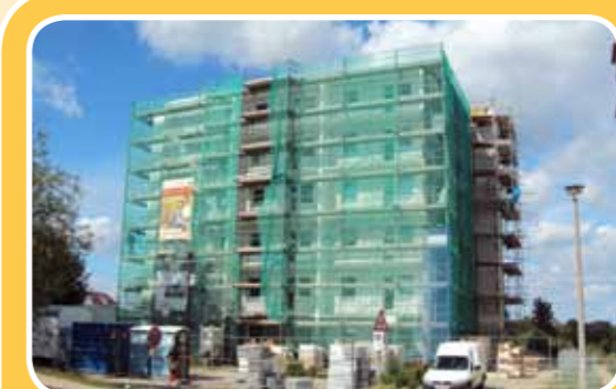
Neptunring 2: Anbau eines Aufzuges, Erneuerung der Bäder, der Haustechnik, des Daches und der Fassade
