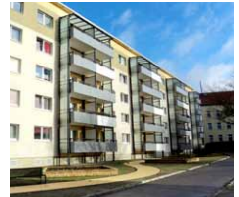
Schönower Chaussee, Neuanlage der Balkone und der Außenanlagen
